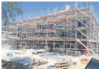
Noch verdeckt das Baugerüst das Haus.
