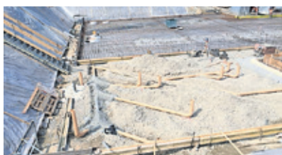
Das Fundament ist gelegt.
