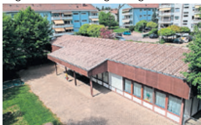
Der alte Pavillon vor dem Abbruch.
